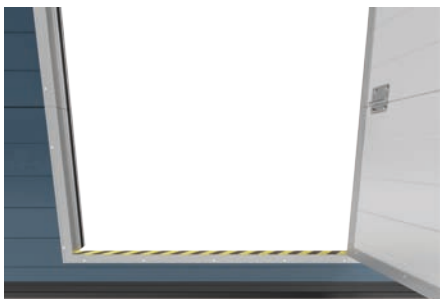
Uszczelnienia gumowe w dolnym profilu drzwi
